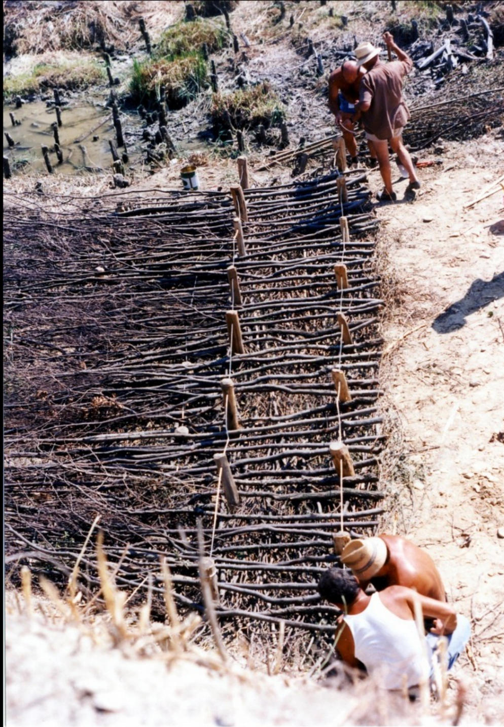
Lavori di manutenzione alla 'Steccaia leonardesca'
